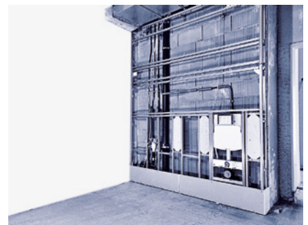
↑ Leidingen worden aangesloten.
